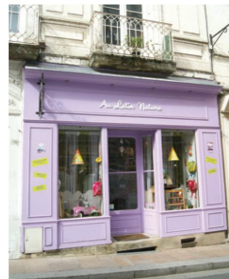
2 | Lorsque la devanture est installée dans la largeur des ouvertures existantes au rez-de-chaussée, on parle alors de devanture en feuillure\* ou en tableau. C'est une méthode plus ancienne qui a le mérite de conserver l'unité de la façade. La devanture commerciale vient se « nicher » dans la maçonnerie de la façade.
