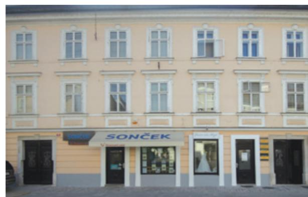
Exemple d'une façade composée en respectant les travées. Chaque étage est marqué par un bandeau, on distingue bien les appuis et les linteaux des fenêtres. La devanture commerciale est intégrée en respectant les travées et les accès privés de l'immeuble.
