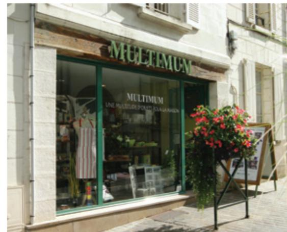
Une large ouverture, sans soubassement, nécessite souvent un châssis métallique.
