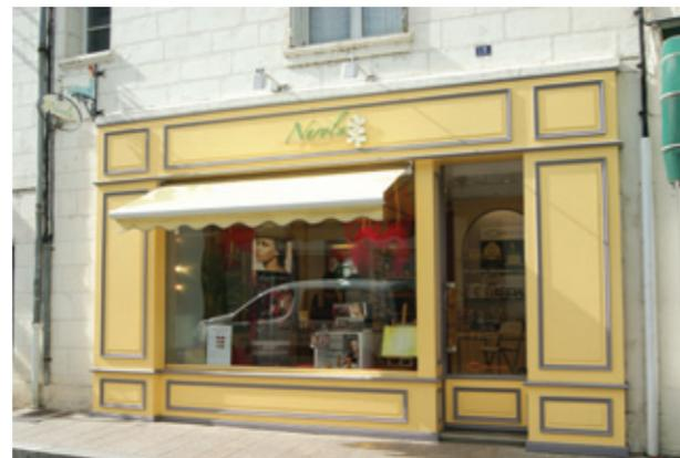
Devanture en applique simple qui permet de bien distinguer le commerce en rez-de-chaussée et la maçonnerie de l'étage.
