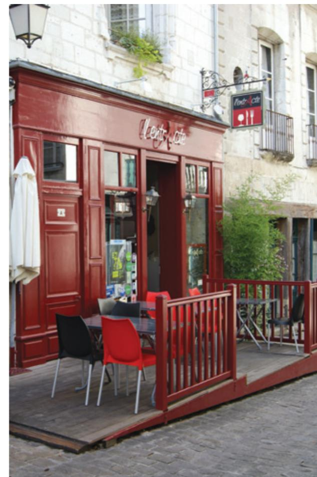
Un plancher en bois peut servir à rattraper la dénivellation de la rue et permettre d'installer une terrasse. Le bois ne doit pas être peint de façon à s'intégrer dans la rue. Ici les rambardes de protection rappellent la teinte de la devanture en applique.
