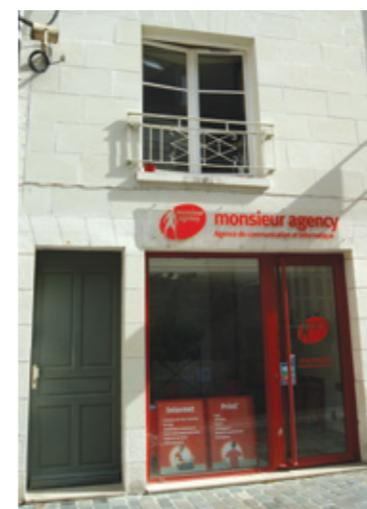
Exemple d'une devanture en tableau (ou en feuillure). La vitrine vient s'insérer directement dans la maçonnerie de l'immeuble, la porte d'accès pour l'étage ne fait pas partie de la devanture commerciale.
