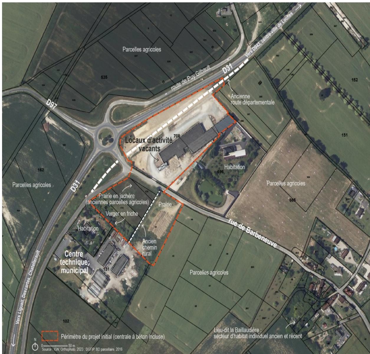
Figure 3 : vue aérienne du site du projet et de son environnement proche
