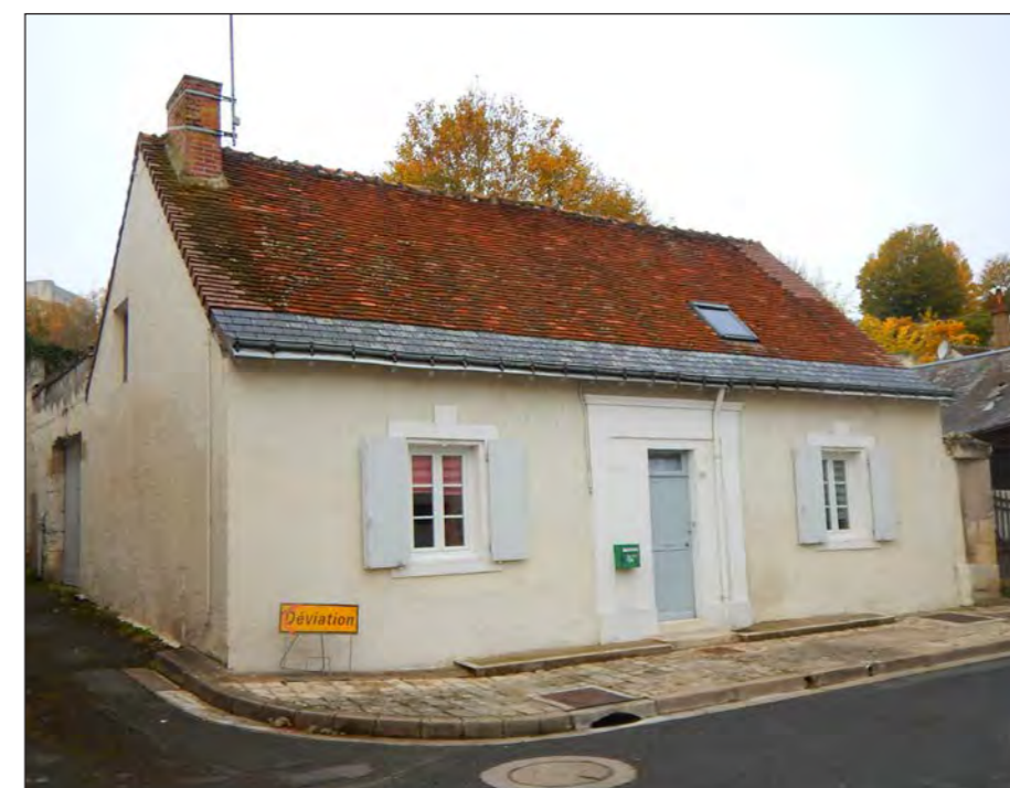
Fig.79 : Bâtiment tardif et sans valeur patrimoniale
