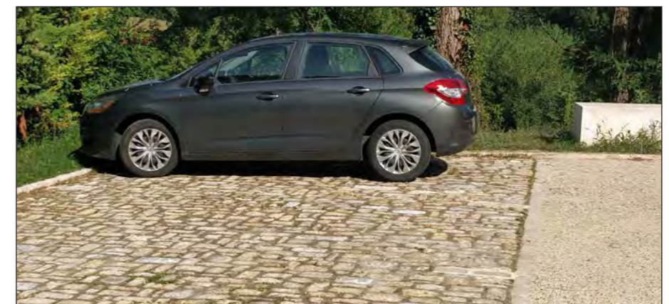
Fig.114 : Exemple de pavages posés avec des joints enherbés qui permettent de conserver une certaine perméabilité. Aubeterre-sur-Dronne (16).
