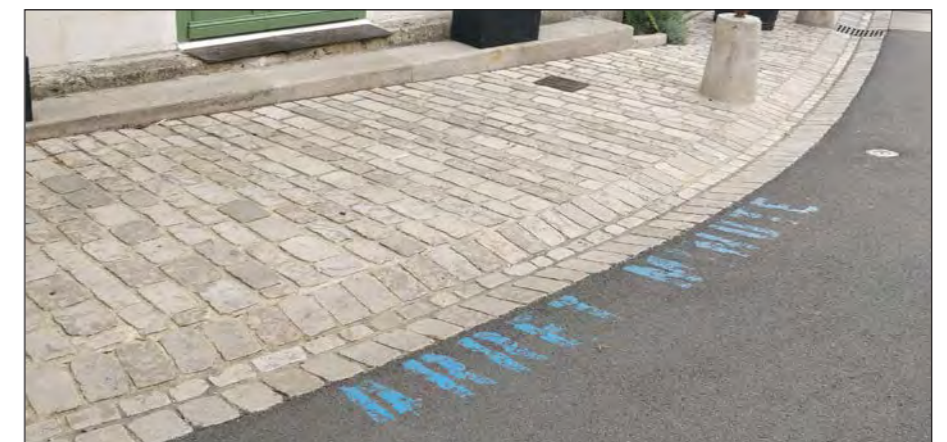
Fig.119 : Un stationnement indiqué par marquage discret, mais qui n'a pas conditionné l'aménagement global ce qui permet une grande réversibilité. Aubeterre-sur-Dronne (16).
