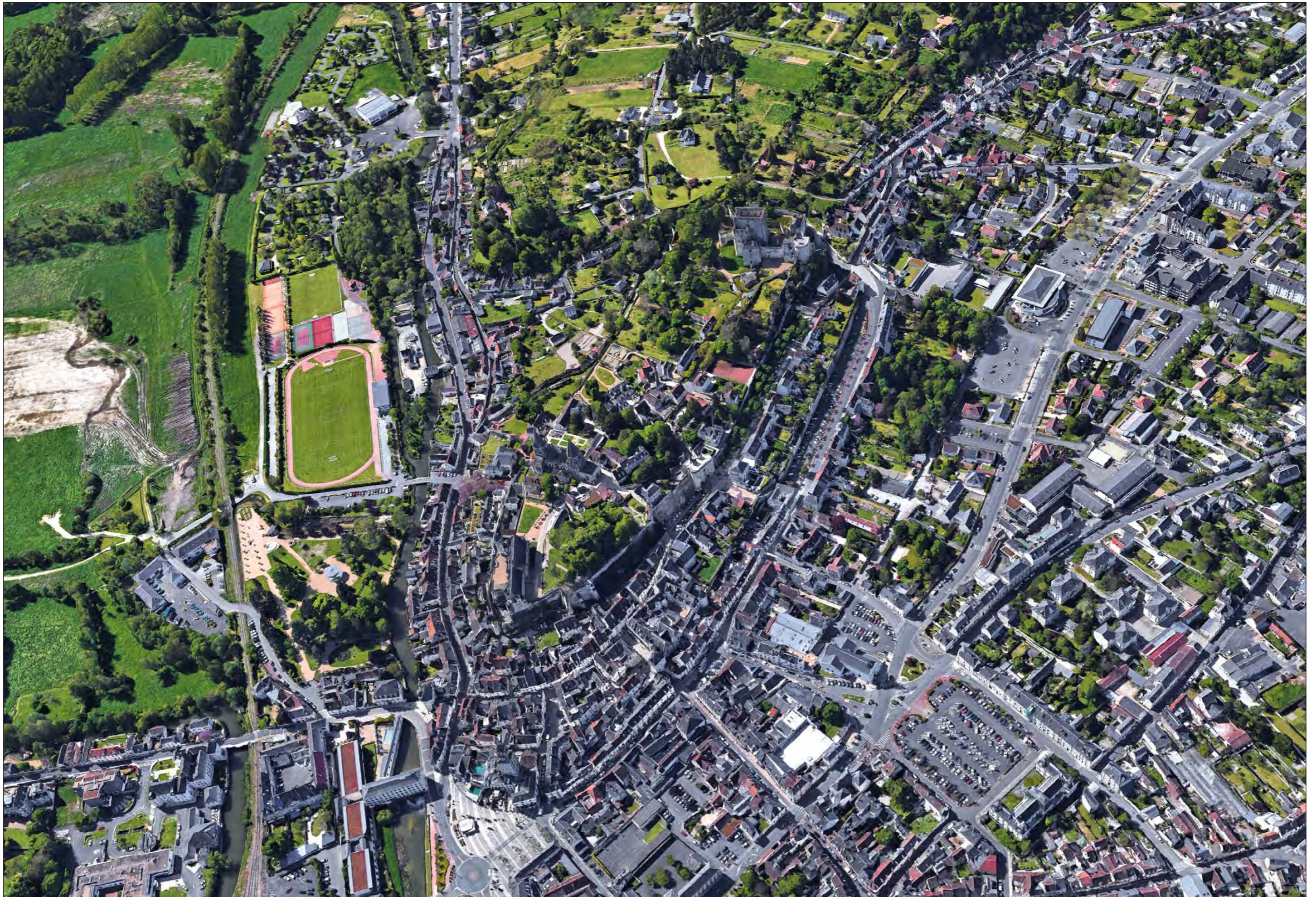
Fig.137 : Vue aérienne de la cité royale sur son éperon rocheux (source : Google Earth 2018)
