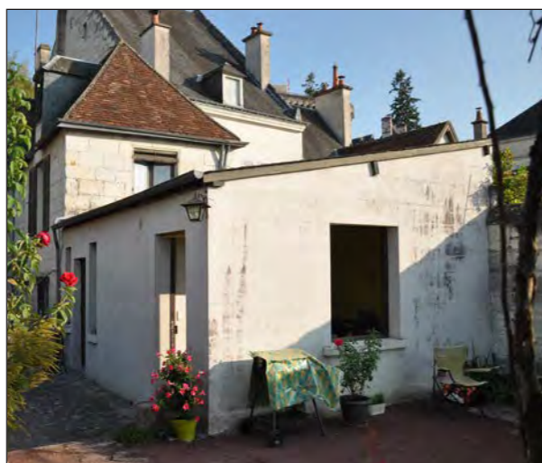
Fig.82 : Proportions et dessin des ouvertures déséquilibrés
