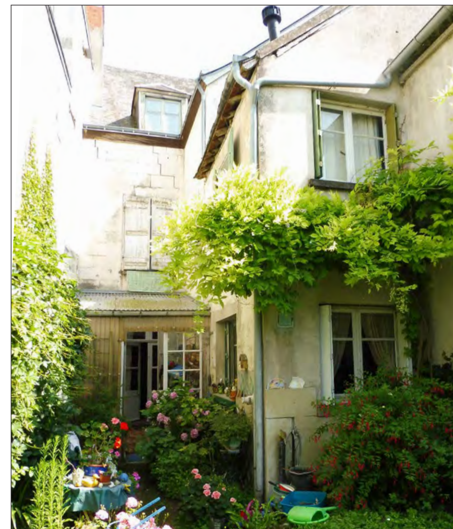
Fig.86 : Exemple de matériaux de toiture et de bardage inadaptés au bâti et au contexte patrimonial
