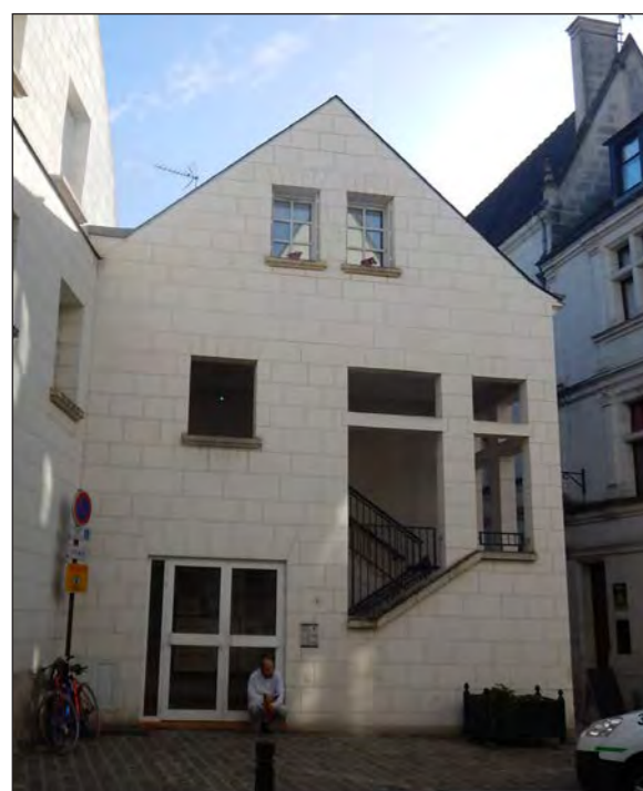
Fig.77 : Bâtiment sans valeur historique ni patrimoniale
