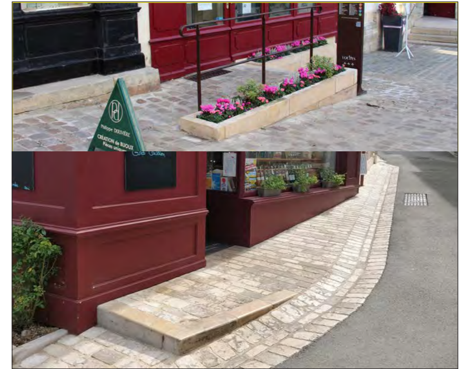
Fig.117 : Exemples harmonieux (Loches en haut, SPR d'Aubeterre-sur-Dronne (16) en bas) de mise aux normes d'accessibilité intégrées aux aménagements de l'espace public.
