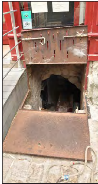
Fig.48 : Rue du Château
