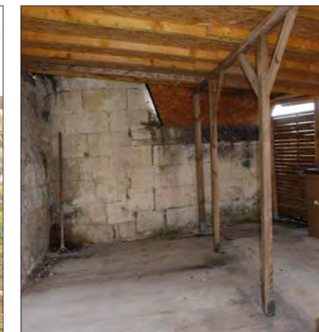
Fig.64 : Bâtiment qui ne s'intègre pas dans le paysage patrimonial de la cité.
