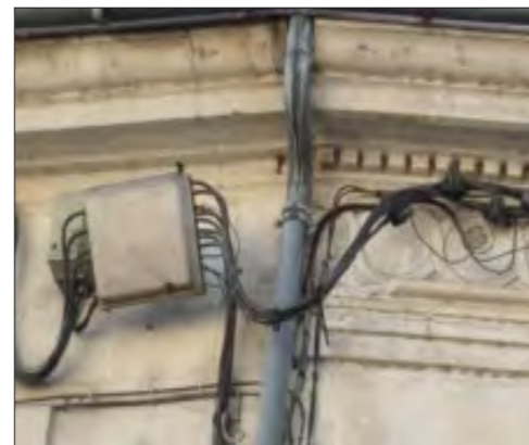
Fig.13: Couleur d'un revêtement isolant de protection des câbles non similaire à la teinte de la façade
