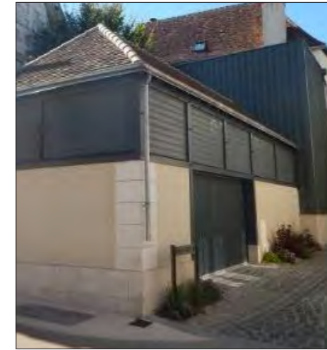
Fig.4 : Présence de matériaux contemporains
