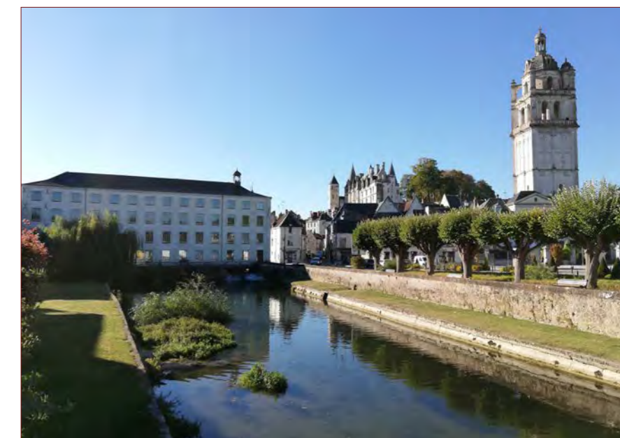
Fig.138 : Salle de séminaires du Moulin des Cordeliers à Loches
