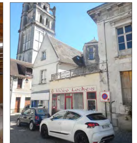
Fig.65 : Bâtiment qui ne s'intègre pas dans le paysage patrimonial de la cité.
