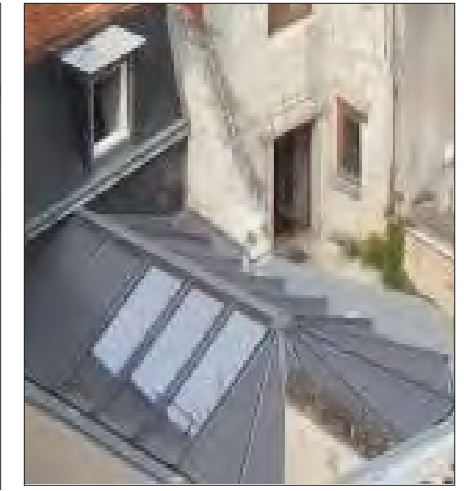
Fig.5 : Exemple de couverture en zinc prépatiné
