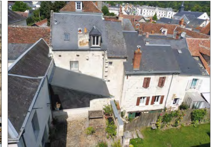
Fig.57 : Bâtiment sur façade arrière difficilement secourable.
