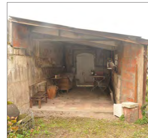
Fig.63 : Bâtiment qui ne s'intègre pas dans le paysage patrimonial de la cité.
