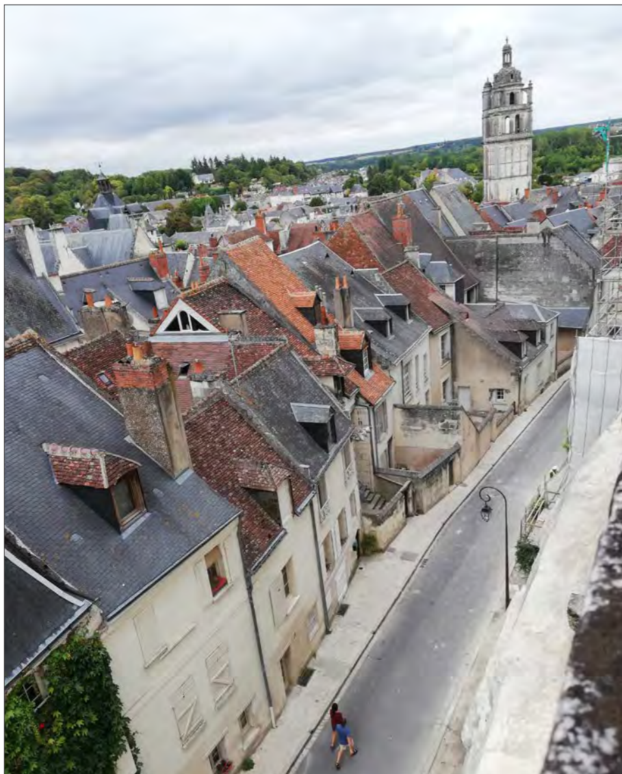
Fig.170 : Vue sur la ville depuis les remparts de la forteresse royale
