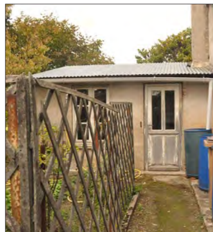
Fig.62 : Bâtiment qui ne s'intègre pas dans le paysage patrimonial de la cité.
