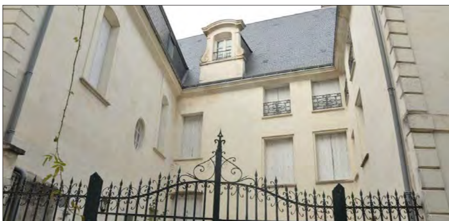
Fig.27 : Photographie actuelle de l'immeuble
