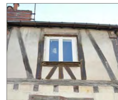
Fig.9 : Exemple de pan de bois
