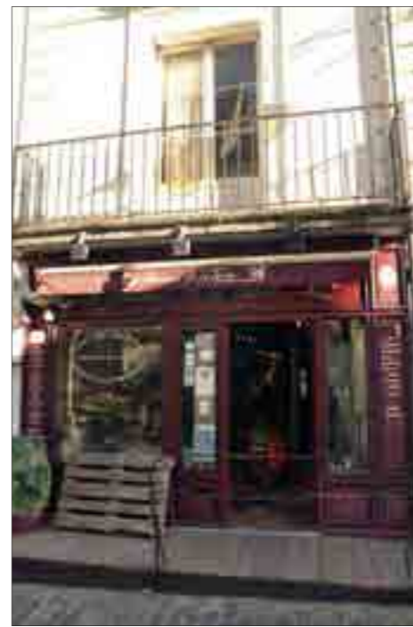
Fig.223 : Façade étroite rue Balzac
