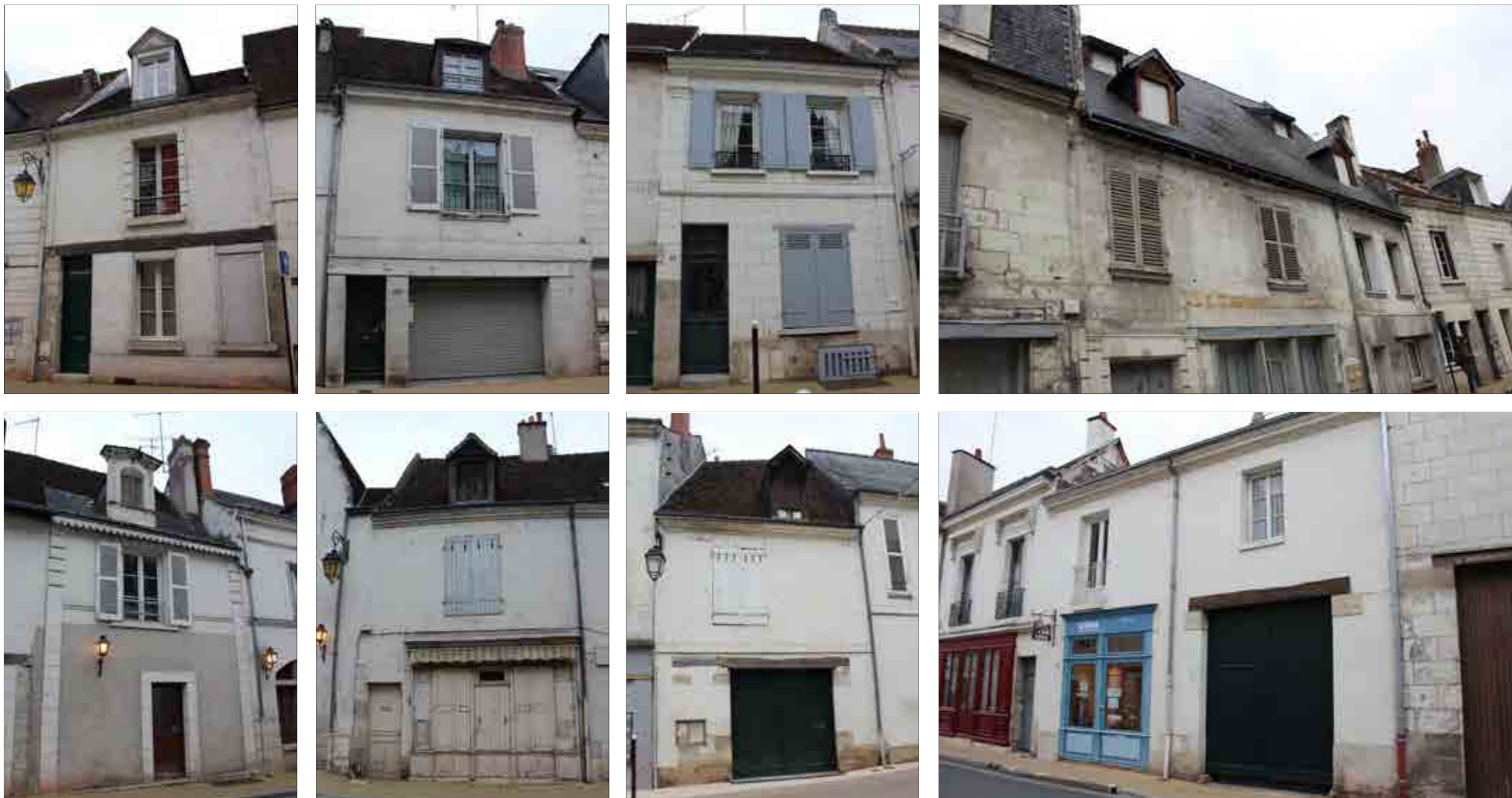
Fig.276 : Petits immeubles de faubourg, présentant des façades datées principalement du XIX e siècle, avec des formes récurrentes : un seul étage surmonté d'une lucarne , une à deux travées, un commerce ou une porte de garage décentrée, une écriture simple, des contrevents ou persiennes à la fenêtre de l'étage, etc.
