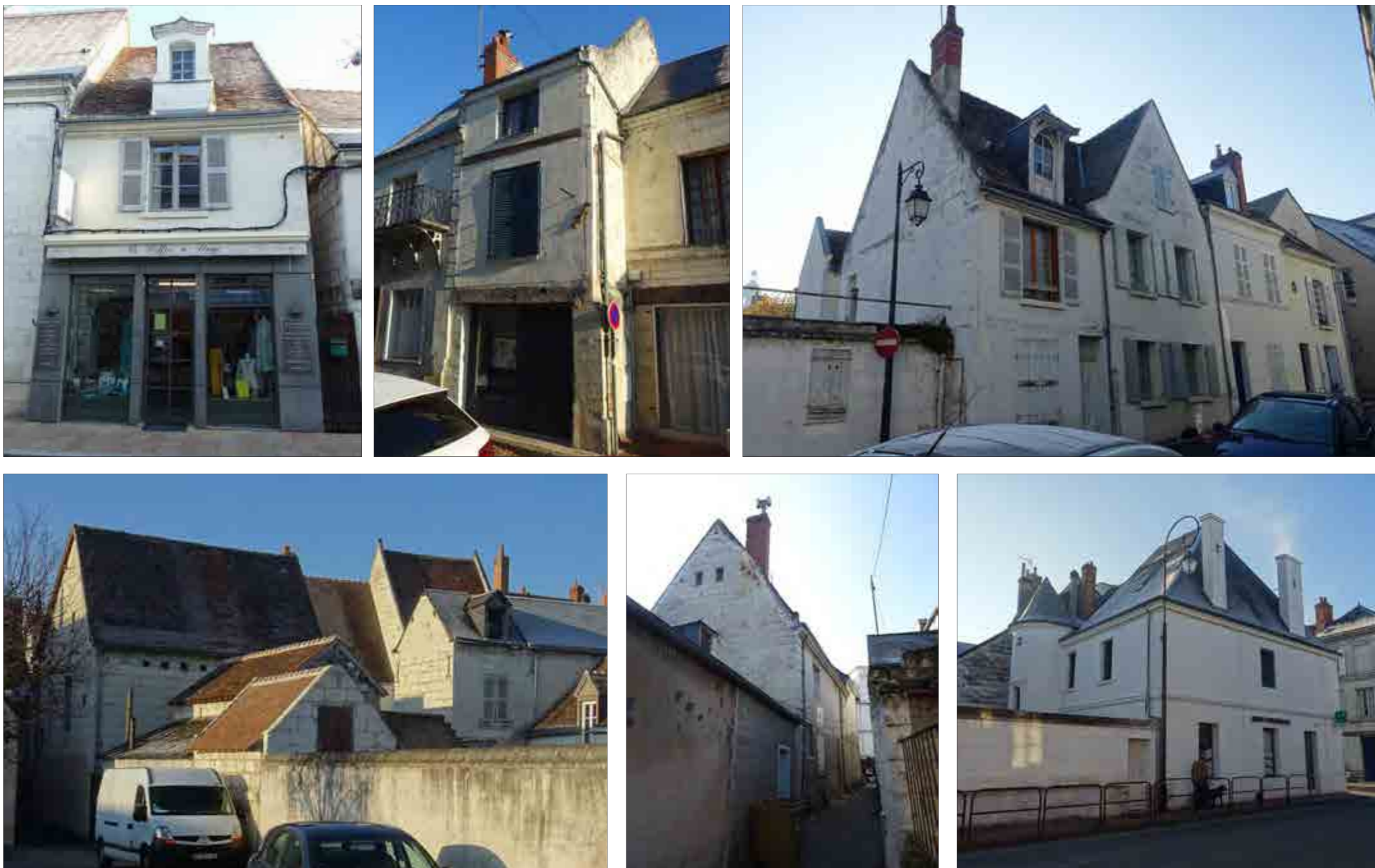
Fig.270 : Bâti similaire au secteur « centre » : façades présentant des caractéristiques du XVIII e et du XIX e siècle, mais présence récurrente d'éléments témoignant de constructions médiévales : rondelis, croisées, tours d'escaliers, etc.
