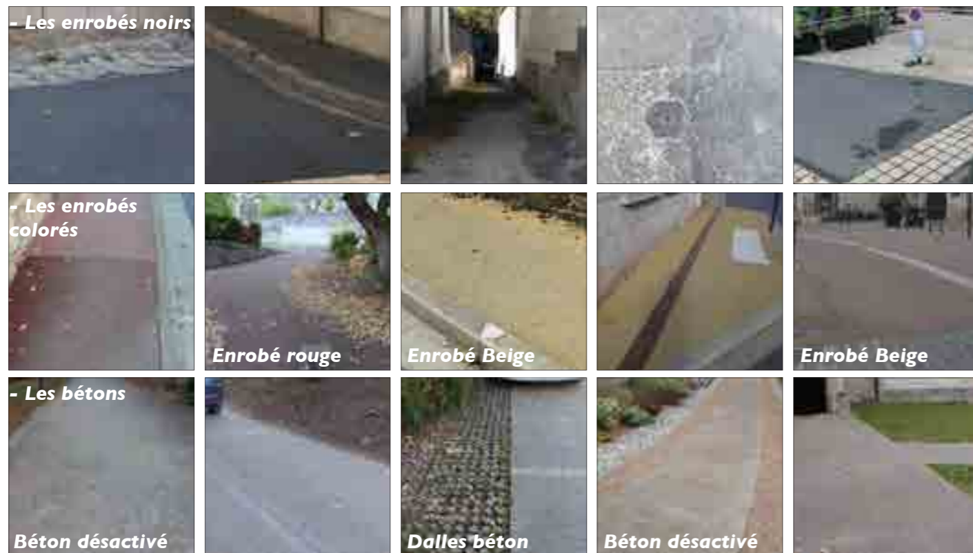
Fig.329 : Une réelle diversité entre les revêtements en enrobé et en béton : enrobé gris-noir, enrobés colorés rouge ou beiges, enrobé et pavages, béton désactivé, dalles béton préfabriquées, etc.
