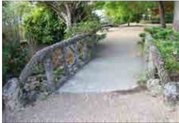
Fig.384 : Élément architectural du jardin, le pont rustique en béton imprimé de fausses nervures de bois rappelle la nature, comme de nombreux éléments « pittoresques » de l'époque
