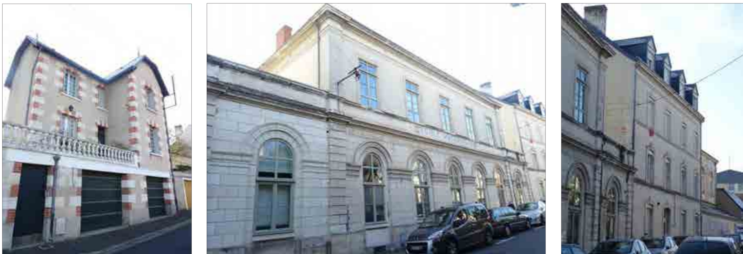
Fig.292 : Les arrières de la place concentrent les rares exemples dans le périmètre du SPR d'une architecture que l'on retrouve dans l'ensemble de la France au cours du XIX e siècle et au début du siècle suivant
