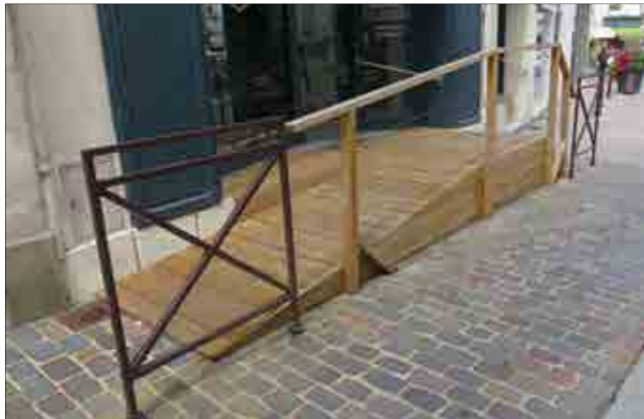
Fig.324 : Les AOT permettent des aménagements ponctuels, discrets s'ils sont bien réalisés et qu'ils respectent les prescriptions, qui peuvent permettre l'accessibilité des commerces. Source photo : Ville de Loches.
