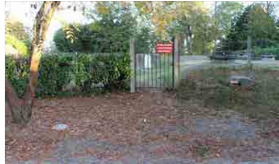
Fig.402 : La parcelle des réservoirs, située à l'entrée du site du donjon. La signalétique, le portail et la clôture apportent une ambiance paysagère technique peu intégrée qui n'est pas valorisante pour l'entrée principale du site.
