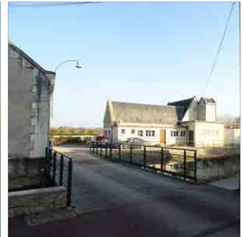
Fig.296 : Immeubles Installations industrielles sur le cours d'eau
