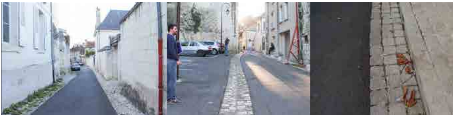
Fig.325 : Quelques exemples intéressants de réalisation mêlant enrobé et pavages de pierres.
