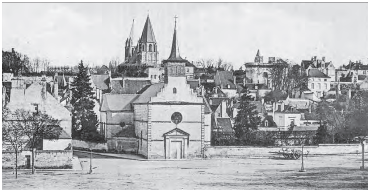
Fig.367 : Le jardin arboré du presbytère clôt par un muret en pierre et une haie taillée, Delcampe
