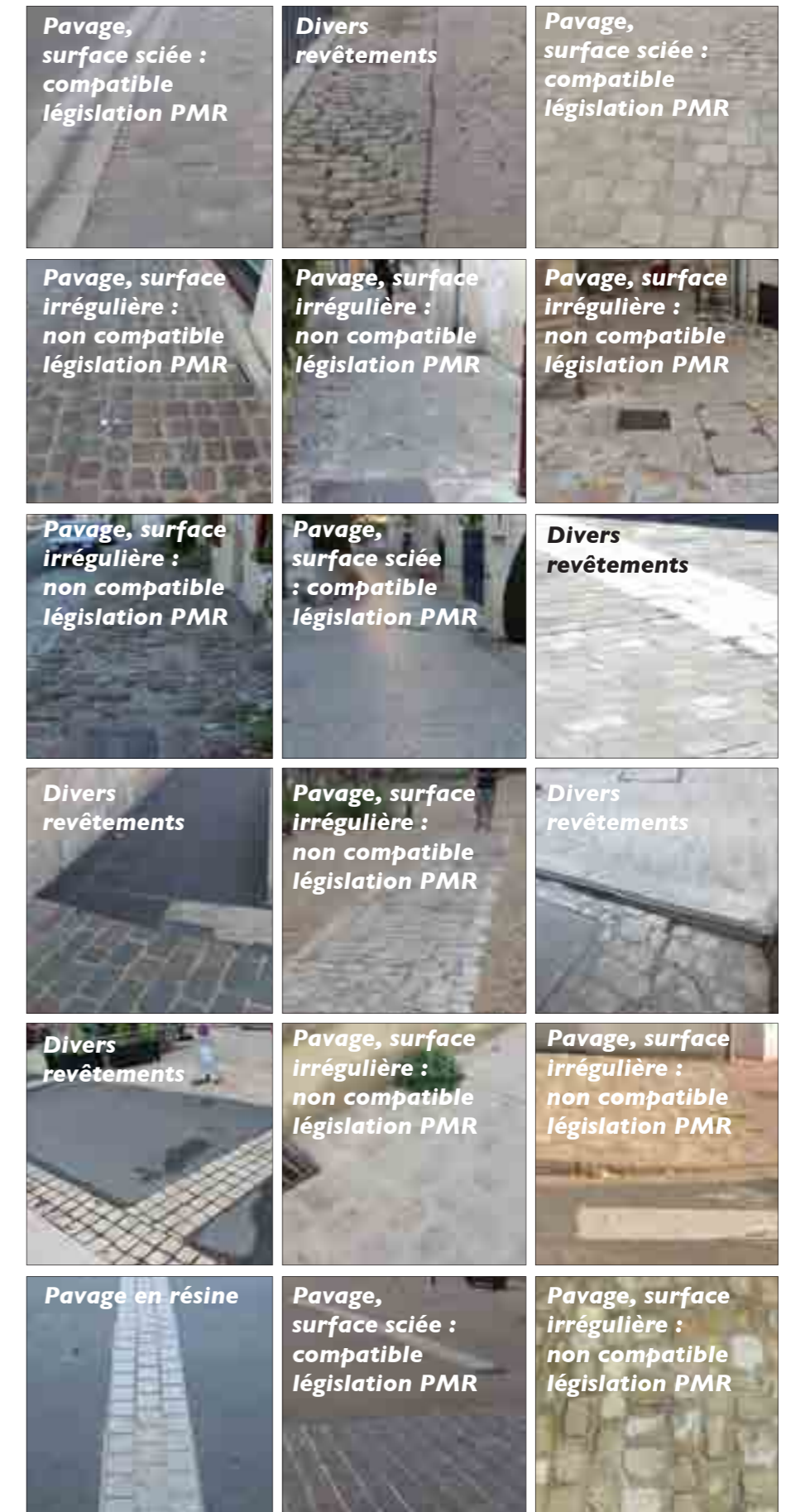
Fig.326 : Diversité des pavages dans le Site Patrimonial Remarquable : l'enjeu est de trouver une homogénéité dans les formes et les couleurs ainsi que dans le traitement de la surface qui puisse notamment faciliter les liaisons PMR.
