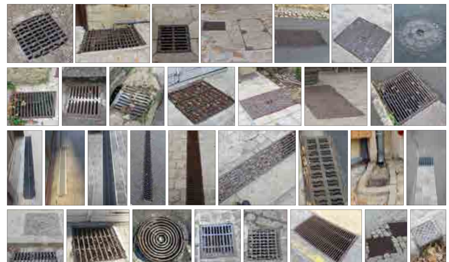
Fig.333 : Si les réseaux doivent être enterrés, rien ne permet de définir une homogénéité dans les modèles de regards implantés sur l'espace public. La fonte constitue le matériel récurrent pour ce type de réalisation, toutefois, les différentes formes d'émergences de ces réseaux sont très disparates.
