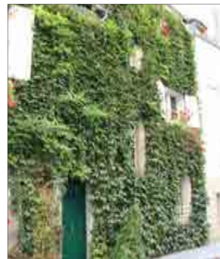
Fig.345 : Façade végétalisée au 22 rue des Fossés Saint-Ours
