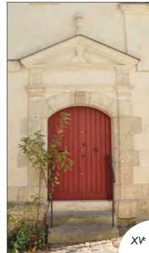
Fig.496 : Rue du Château (8)
