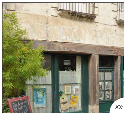
Fig.605 : Rue du Château (15)
