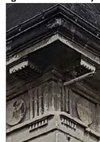
Fig.429 : Détail encrassement
