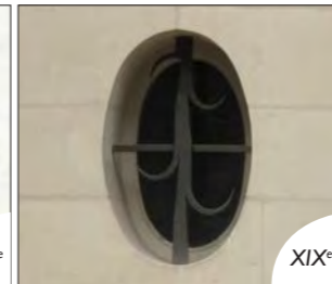
Fig.492 : Rue du Château (7)
