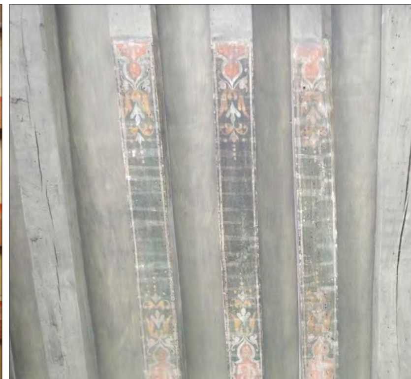
Fig.802 : Rue du Balzac
