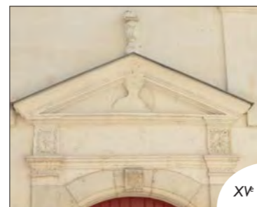
Fig.625 : Rue du Château (4)
