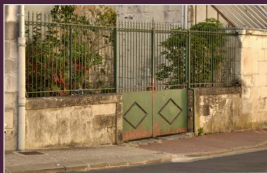
Exemple de mur bahut traditionnel
