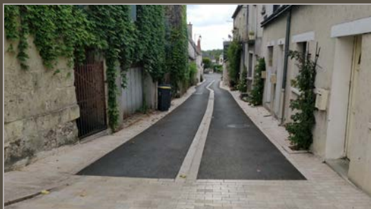
Enrobé et pavages, calepinage globalement parallèle à la voirie, Villandry (37)
