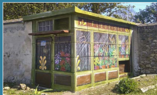
Exemple de poste électrique peint (src. ENEDIS)
