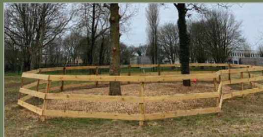
Protection des arbres lors des chantiers
