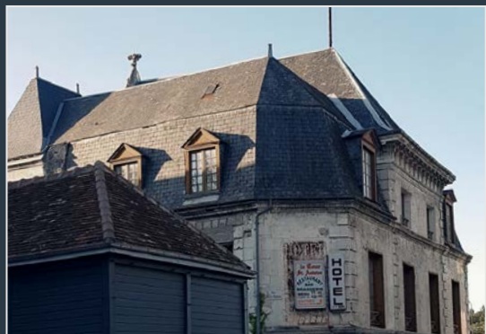
Couverture en ardoises
