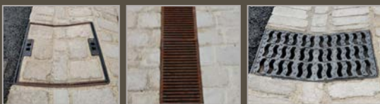
Grilles et regards intégrés au calepinage
