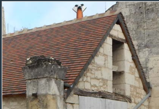
Couverture en tuiles plates
