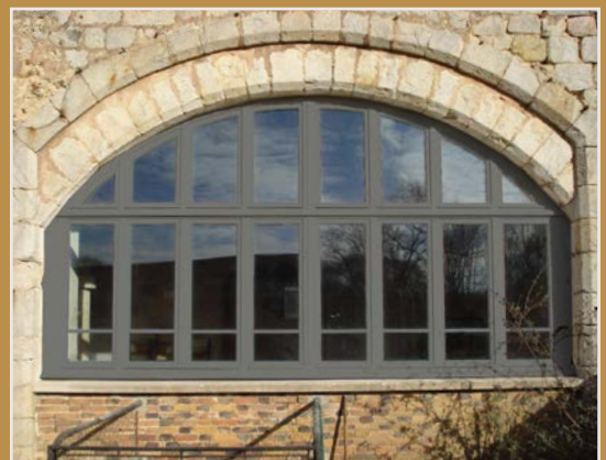
Menuiserie dans une ouverture cintrée
