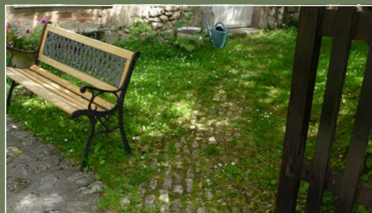
Exemple de revêtement perméable dans un jardin privé. Angles-sur-l'Anglin (37)
