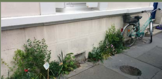
Végétalisation en pied de façade par des particuliers avec l'accord de la commune : une bonne manière de limiter l'humidité des murs. Espèces vivaces, basses, qui ne s'accrochent pas aux murs. Exemple du permis de végétaliser, ville de Tours (37).
