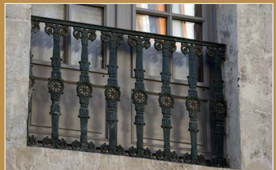
Garde-corps et imposte à conserver et à entretenir
