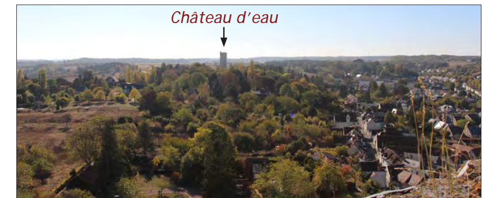
Fig. 13 : Point de vue vers le sud : le château d'eau est un point de repère fort dans le paysage
