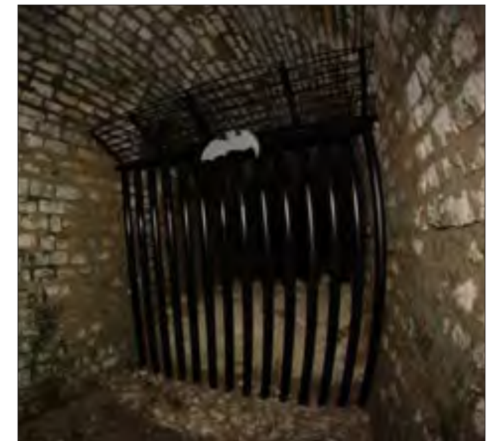
Fig.66 : Exemple de mesures pour préserver les gîtes à chauve-souris. Source : CONSERVATOIRE D'ESPACES NATURELS DE BOURGOGNE
