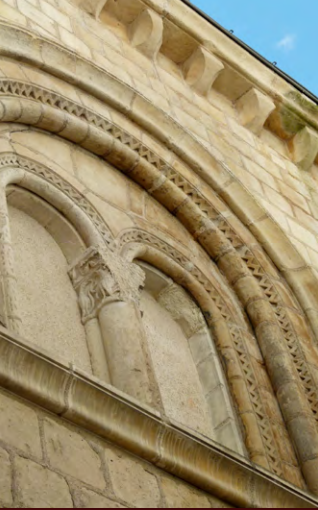
Baies géminées d'une maison romane située dans le quartier du Vieux Tours
